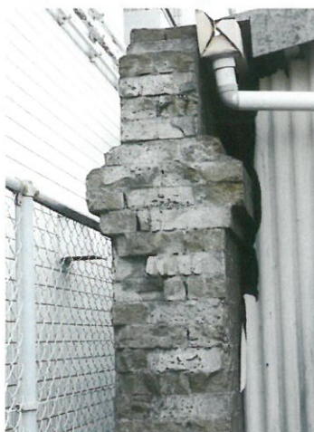
現在駐車場の基礎となっている昔の建物の一部
